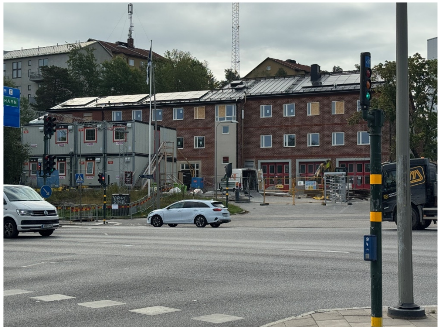
Nyrenoverad fasad med omfogning, ny puts och ombyggda fönster. Nytt tak med ny stomme, plåt och solceller.
